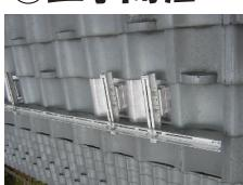
瓦屋根の場合、専用の金具と横桟を取り付け、太陽電池モジュールを設置します。その後、電気屋さんが屋内配線工事や分電盤、電力モニターパワーコンディショナーの取付工事を行います。工期は約2～4日間で完了します。
