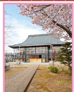
本堂回廊改修及び風除工事
