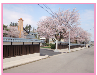
境内木塀工事
