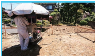
地盤調査の様子
