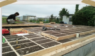
床チャコパネル施工
