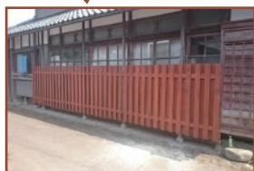
M様邸にて古くなったトタンの塀をヒノキの板に替える工事をさせて頂きました。柱だけ残し、横棧を柱に打ちつけ、交互に板を張っていきました。塗料は防腐剤入の赤寄りのブラウン系を使い、塗装するととってもオシャレに仕上がりました。(知久)
