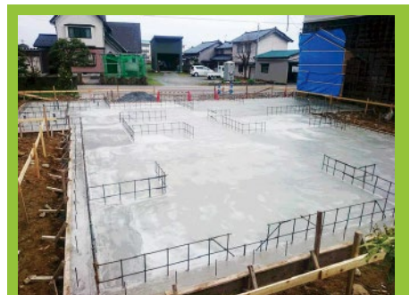
基礎工事、着々と進行中
