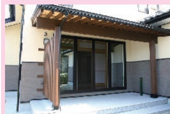
縁側から外に出るとゆったりと大きな土縁が雨や強い日差しを遮ってくれます。
